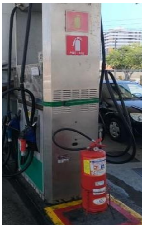
Figura 24: Extintor do tipo PQS 6 kg
