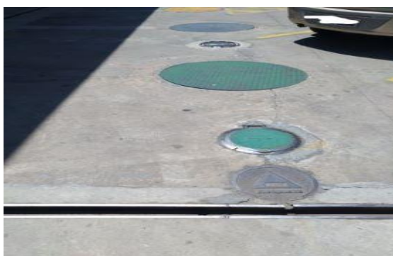
Figura 20: Pontos de descarga de combustível
