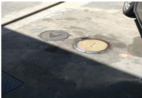
Figura 21: Ponto de descarga de combustível
